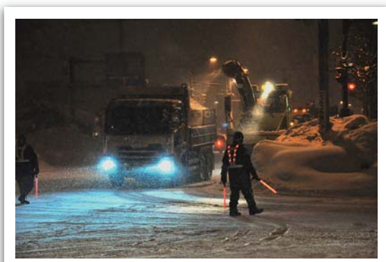
天候の急変に応じ、昼夜を問わず除排雪作業を続け、住民の「命の道」を確保することは、建設業の重要な役目
